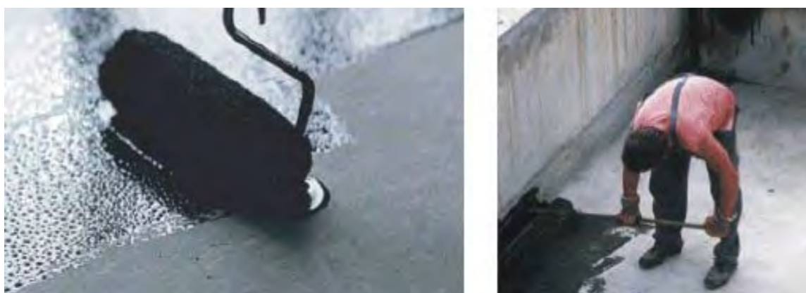
Рис. 5 Нанесение праймера
