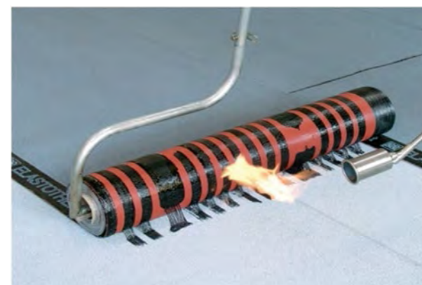
Рис. 14 Укладка материала СИНТАН
